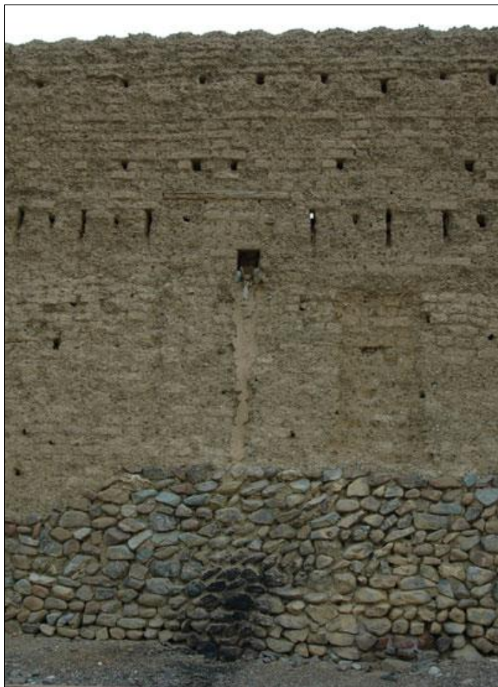
Figuur 34: Moderne bovenbouw aan het fort van Bithnah
