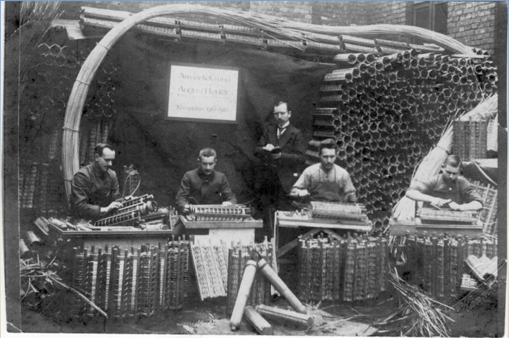
1915 Hannover, "Armee-lieferung". Mallen voor het maken en controleren pasvorm. Verschillende stadia, van bundels rotan tot granaatmand. 40
